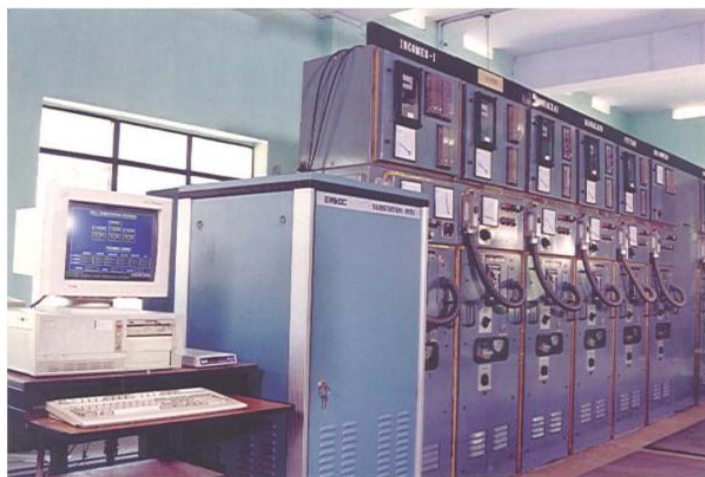
شکل ۶-۷ سیستم کنترل پست در شبکه اتوماسیون
